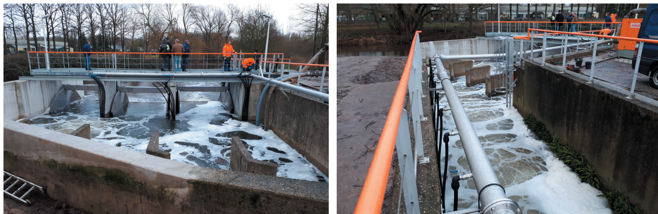
FIGURA 7. O canal de aeração da Estação de Tratamento de Efluentes de Eindhoven em operação total, melhorando a qualidade de oxigênio do efluente antes de reentrar no rio Dommel. Esquerda: Vista da barragem ajustável na saída do canal de aeração. Direita: Vista do canal de aeração a partir da entrada.
