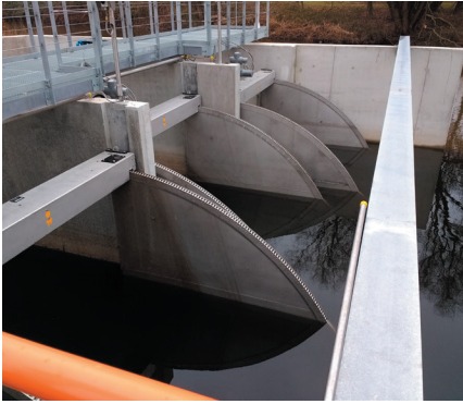
FIGURA 3. Vista da barragem ajustável na saída do canal de aeração.
