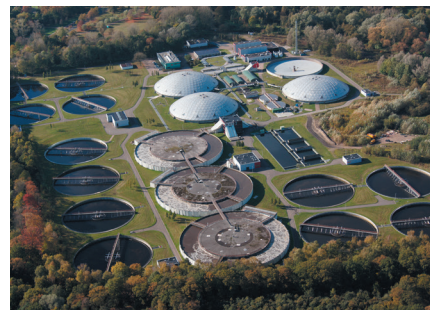
FIGURA 1. Vista aérea da Estação de Tratamento de Efluentes de Eindhoven.
