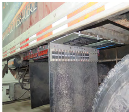
图 2. 上: 经过一年在暴露实验后, 由碳纤维增强聚合物 (carbon-fiber-reinforced polymer, 简称 CFRP) 和 6000 系列铝合金制成的多材料叠层式装配制成的车身上的电偶腐蚀情况。下: 用于车辆运行测试的汽车样件常见安装方式。
