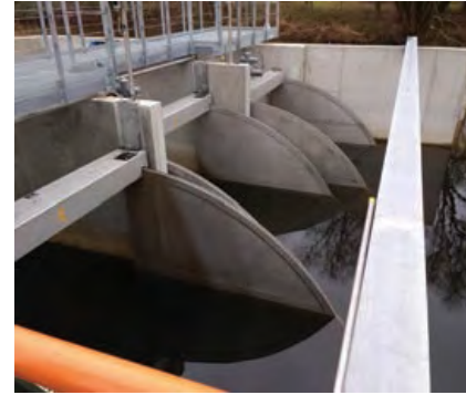
图 3. 曝气通道出口处的可调出水堰。
