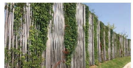
図4 デンマークの高速道路に設置されたPilebygの防音壁。
